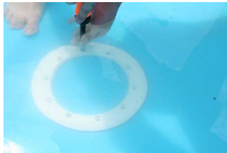
Symbolfoto Flanschring auf Folie befestigen!
